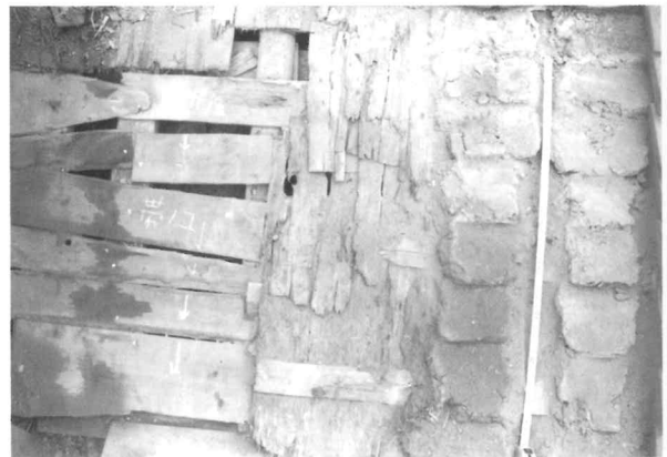
写真22 本建部 野地板「オガ引き・帯ノコ」
