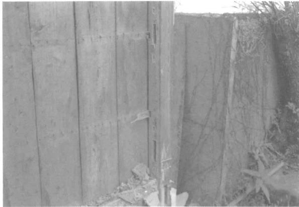
写真20 (いノ五) 柱 貫・間渡し痕跡
