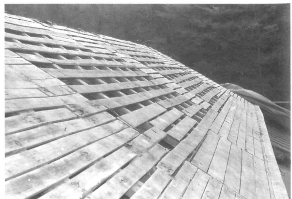
写真23 本建部 野地板「小間返し」
