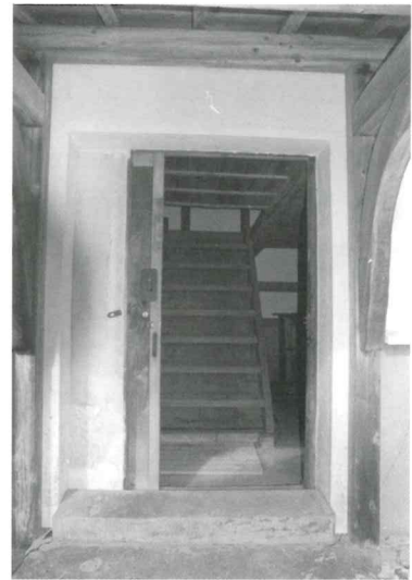
写真31 土蔵出入口扉
