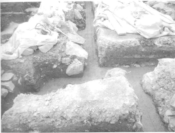
写真5 地中梁捨コン打設
