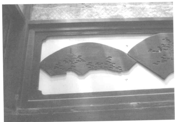
写真25 ランマ欠損部
