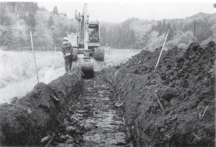
工事立ち会い状況
