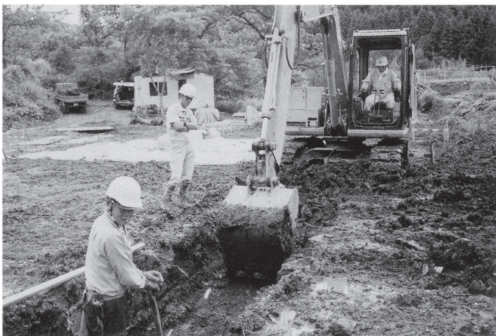
工事立ち会い状況
