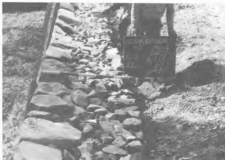
第23図 復修工事による裏栗石の状況
