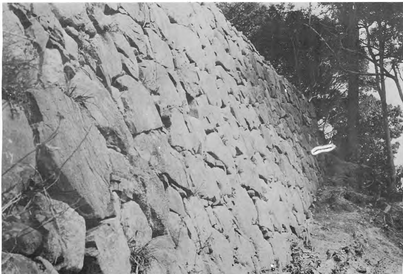
修復後のB石垣
