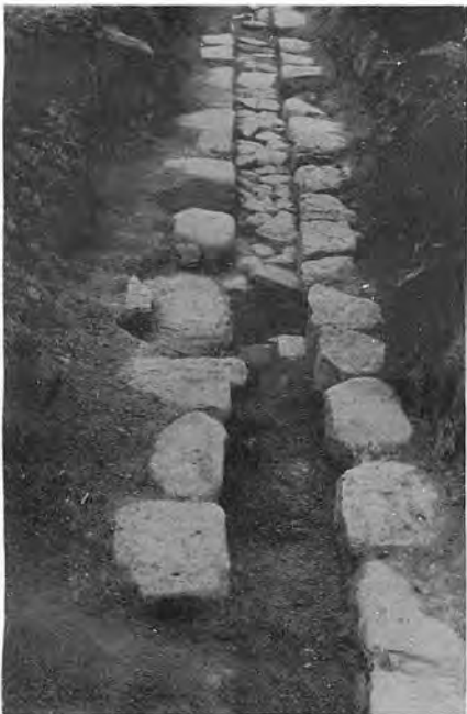
第一排水溝 中央部へ傾斜し、中央部から南へ暗渠となっている
