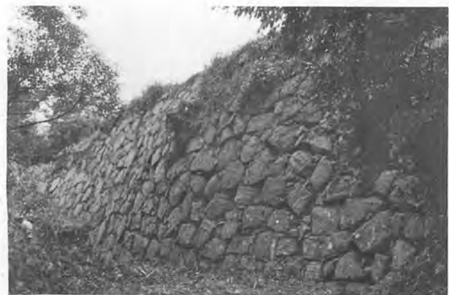
久玉城B石垣 高さ5m、長さ約45mにわたって偉容を誇り、久玉浦に面する部分をかためている。
