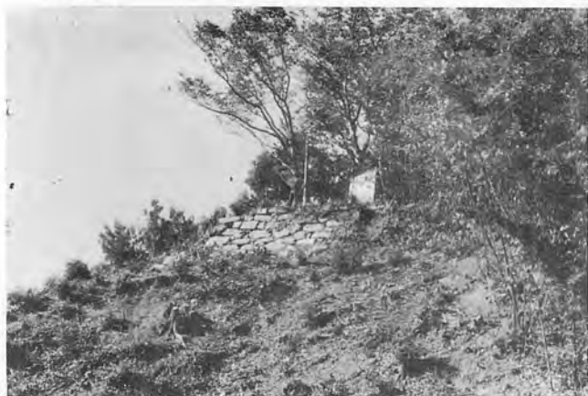
久玉城A石垣。江戸時代に河川改修の石材に転用されたためコーナーの部分失っている。
