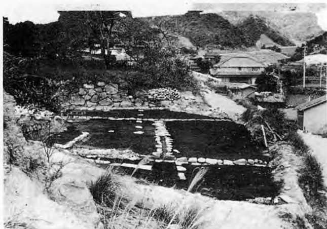
大手部排水溝と北側D石垣（環境整備後）
