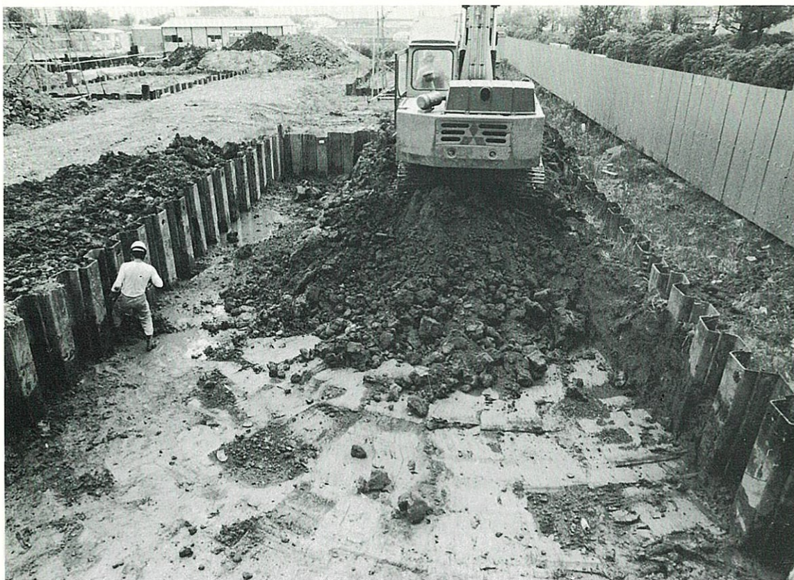
機械掘削風景
