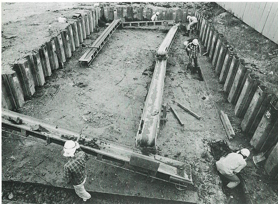
人力掘削風景
