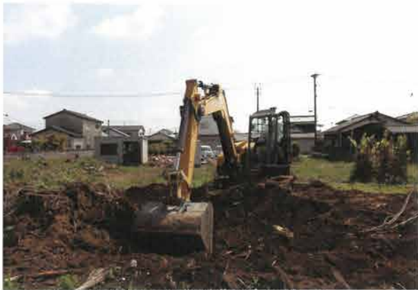
第8図 表土剥ぎ風景（西から）
