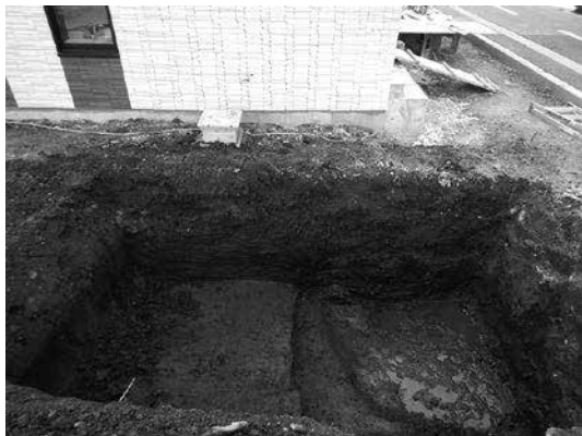
写真28 浸透柵①調査区
