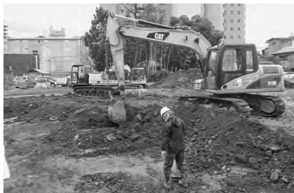
写真2 重機による表土除去作業
