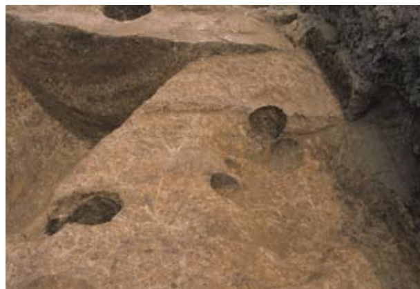
第69図 調査区南部噴砂検出状況（西から）
