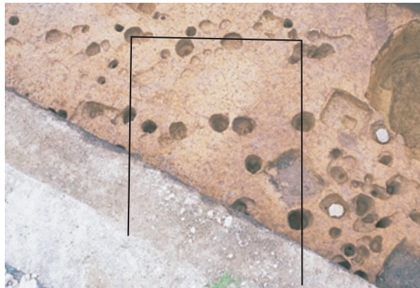
(2) S B 4 完掘状況 (南西上空から)
