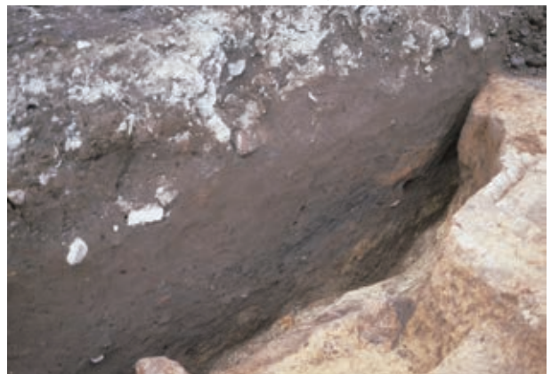
(8) S K 139 完掘状況 (南から)
