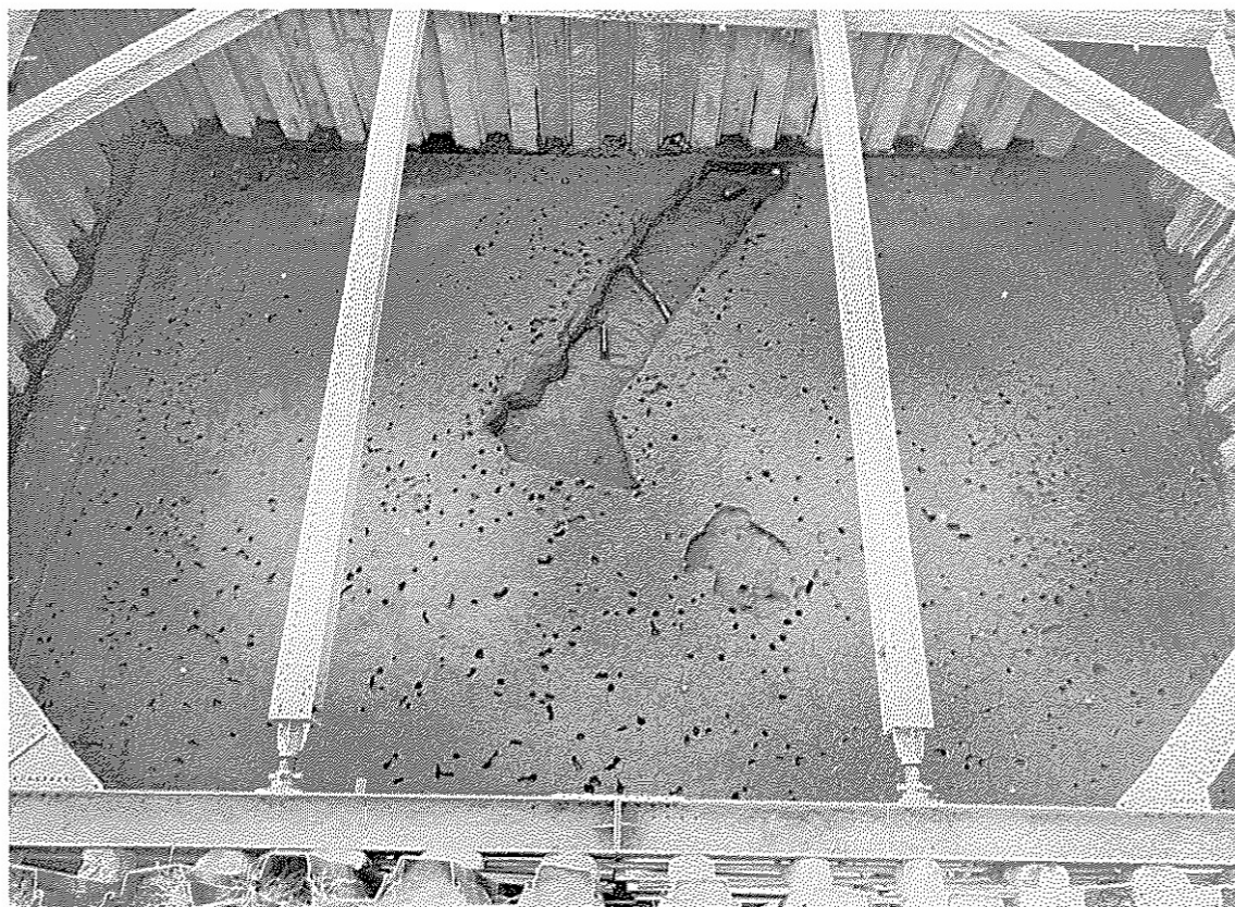
7Bトレンチ 遺構掘削状況(東から)
