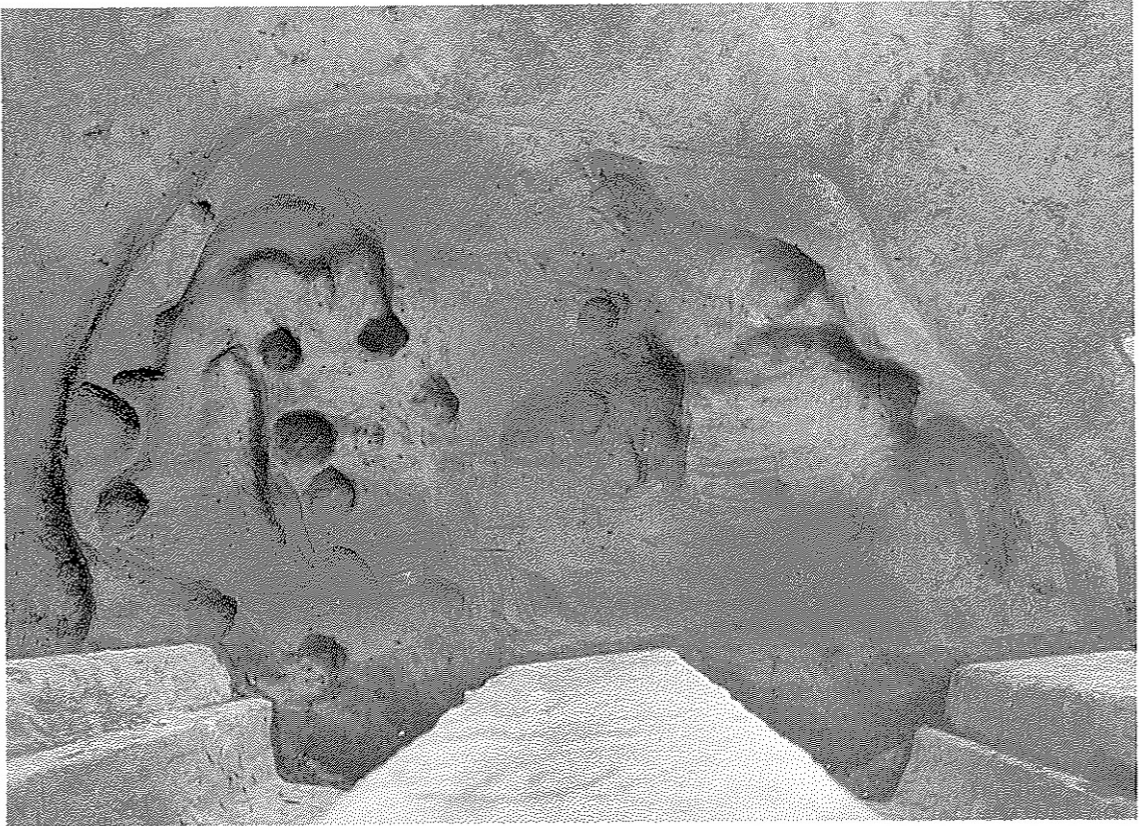
2 Bトレンチ 土壇5掘削状況(南から)
