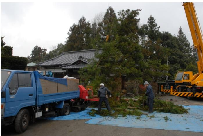
隣地の庭に 25 t クレーンを設置し、チェーンソーによって樹木の上部からの吊切りを繰り返して、伐採を行った。
