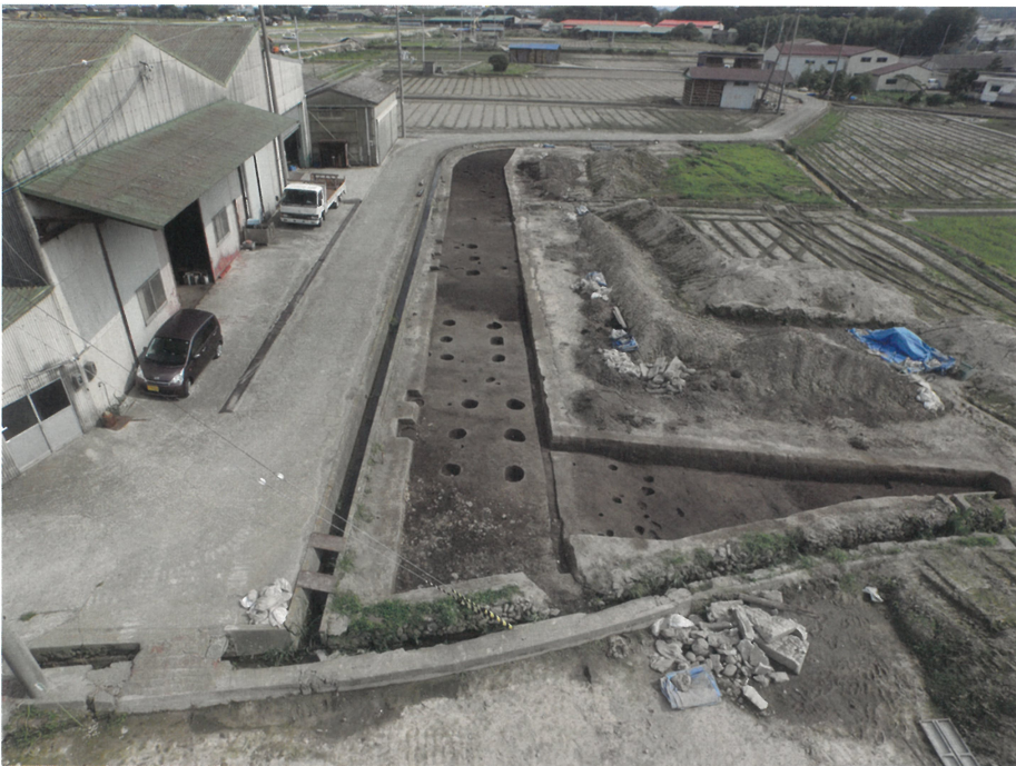
木辺遺跡 3区南（北から）
