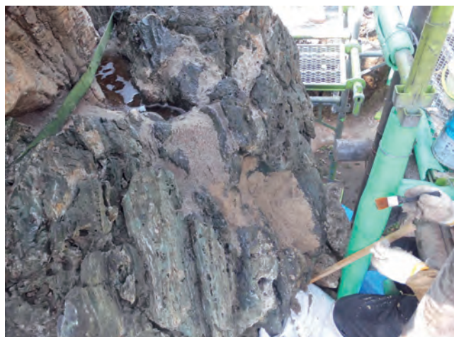
景石の保存修理
