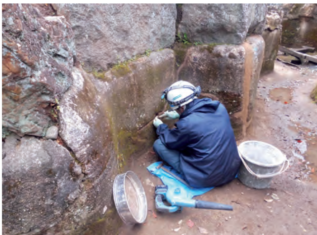
ひび割れ修理
