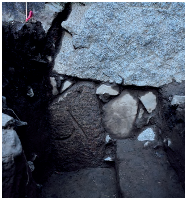
石垣地中部分の状況（西から）
