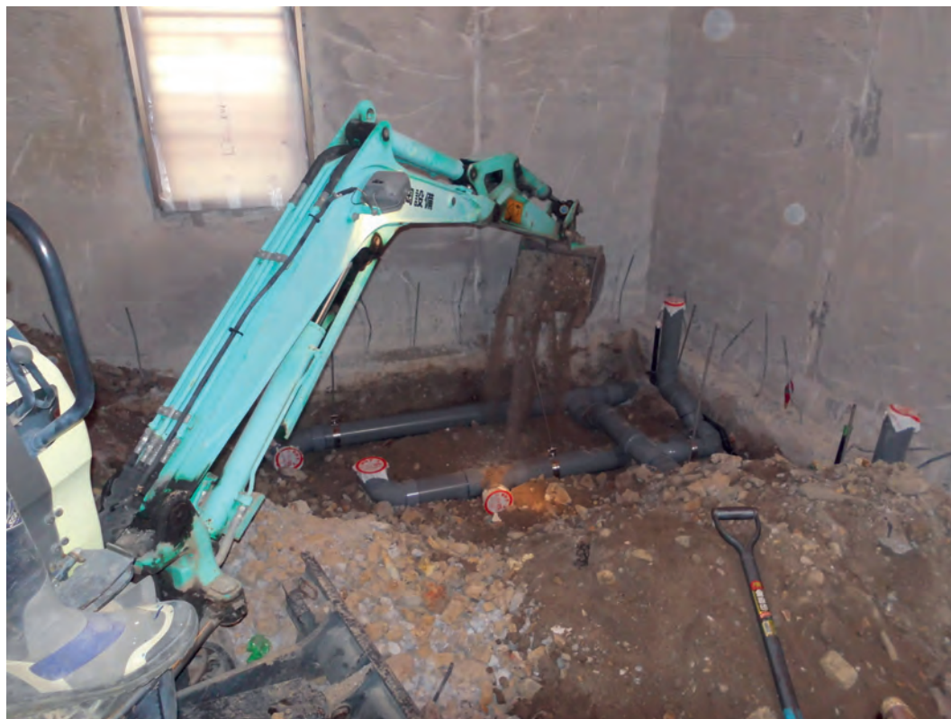
新規掘削立会写真
