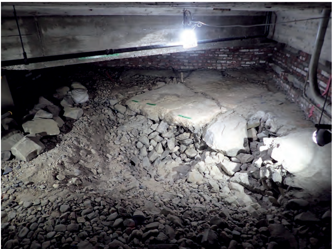
調査区③完掘状況・「コンクリート」敷設面検出（北から）
