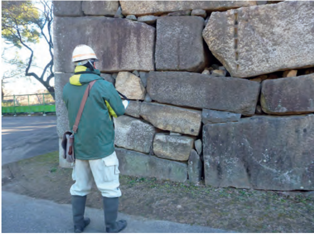
現地調査の様子（123H石垣）
