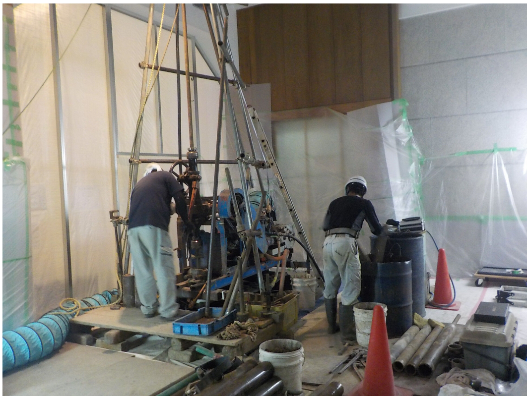
大天守調査番号③における調査風景
