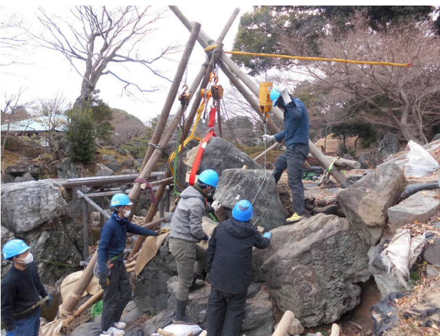
石の据え直し
