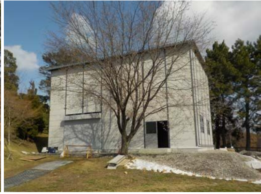
仮設作業小屋設置完了時
