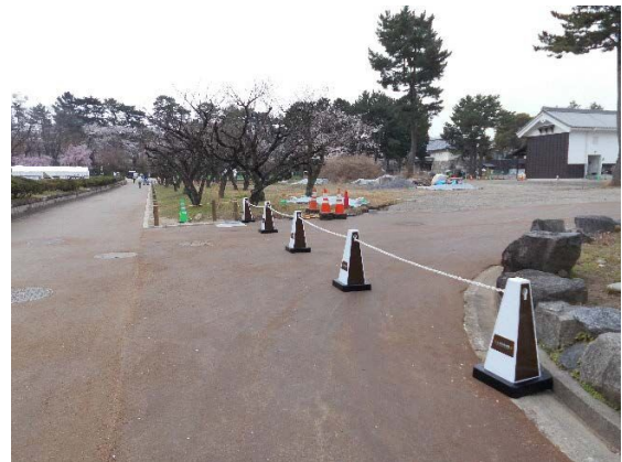
搬出入口付近施工完了風景
