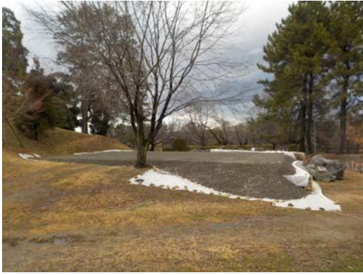
土台造成完了時
