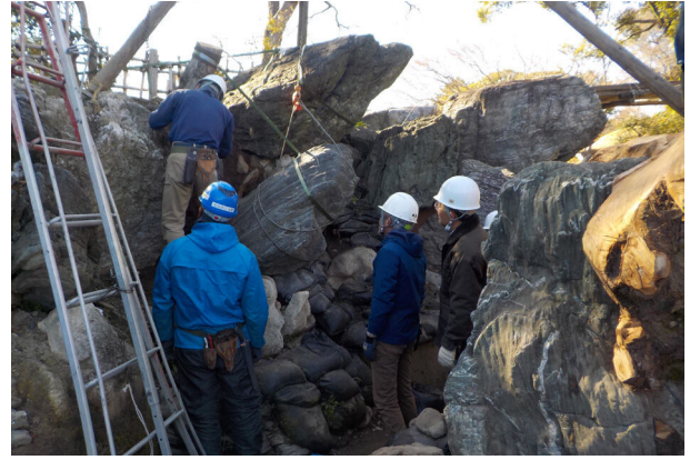
景石の据え直し
