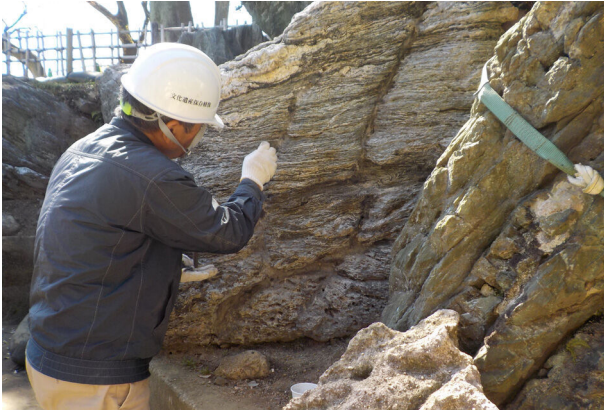
石組の保存修理
