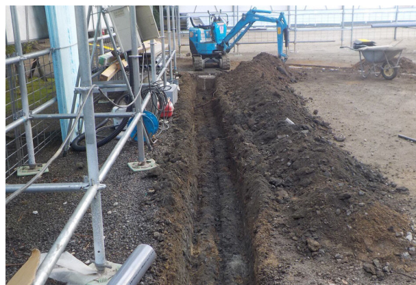
掘削の完了（北から）
