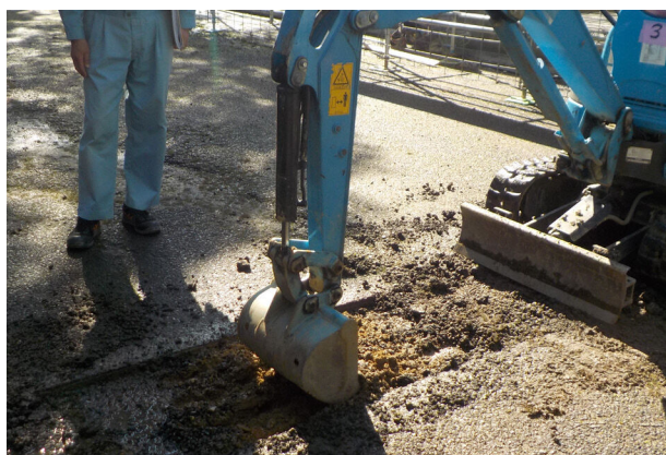
配管工事の掘削状況（北から）
