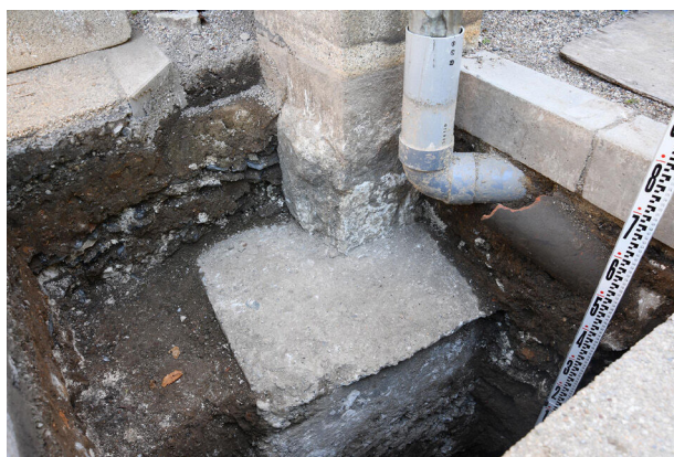
門小屋根控柱の掘削状況（北東から）
