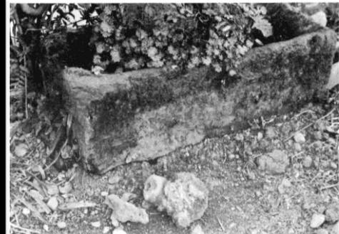
▲かつて同田貫鍛冶場で使用されていた「焼き入れ」用の水槽
