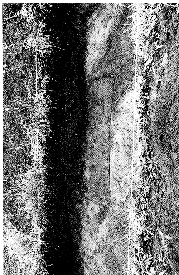
① 第8トレンチ完掘状況 (西から)
