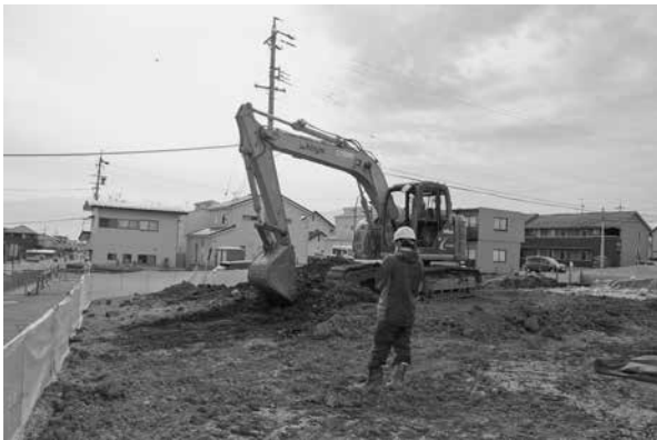
写真1 表土掘削（4月5日）
