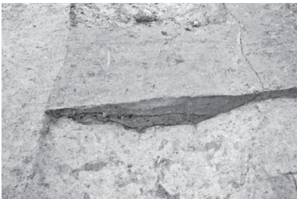
分譲地地点 SD1 断面 (東より)
