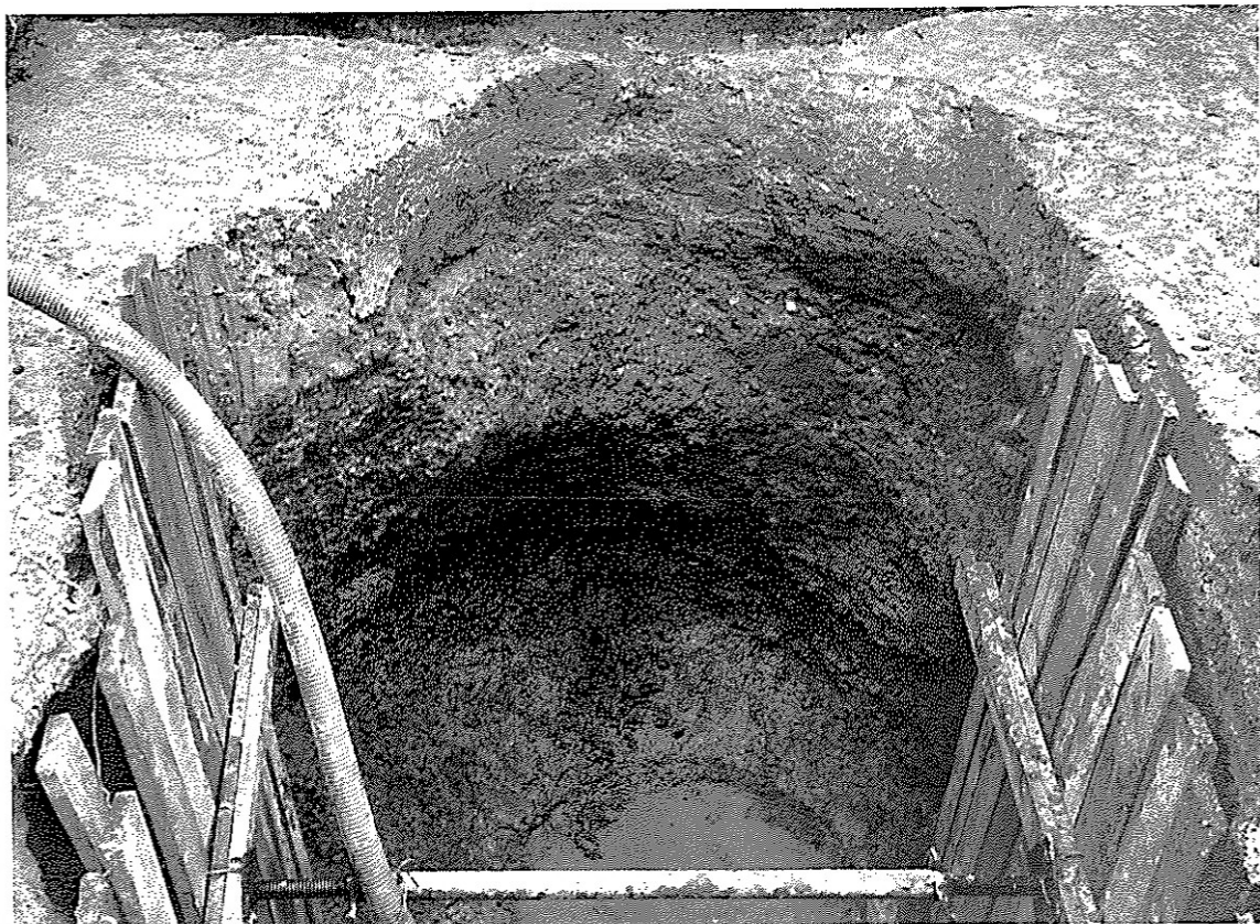
井戸B-1 立ち割り状況（南から）
