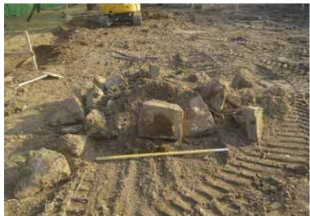
図 1-6 き損した石材の状況
