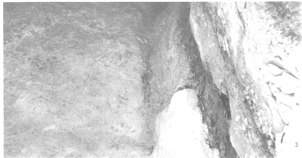
3. 2号横穴 排水溝
