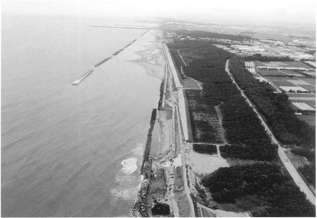
遺跡と金沢海岸(南から内灘方向)
