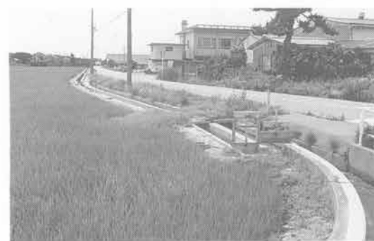
1トレンチ工事完了風景（東から 1991.7.3 撮影）
