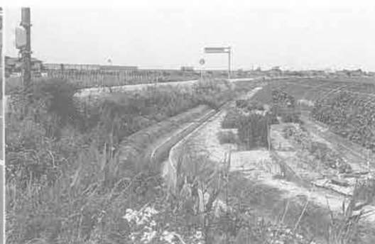
6トレンチ工事完了風景（南から 1991.7.3 撮影）
