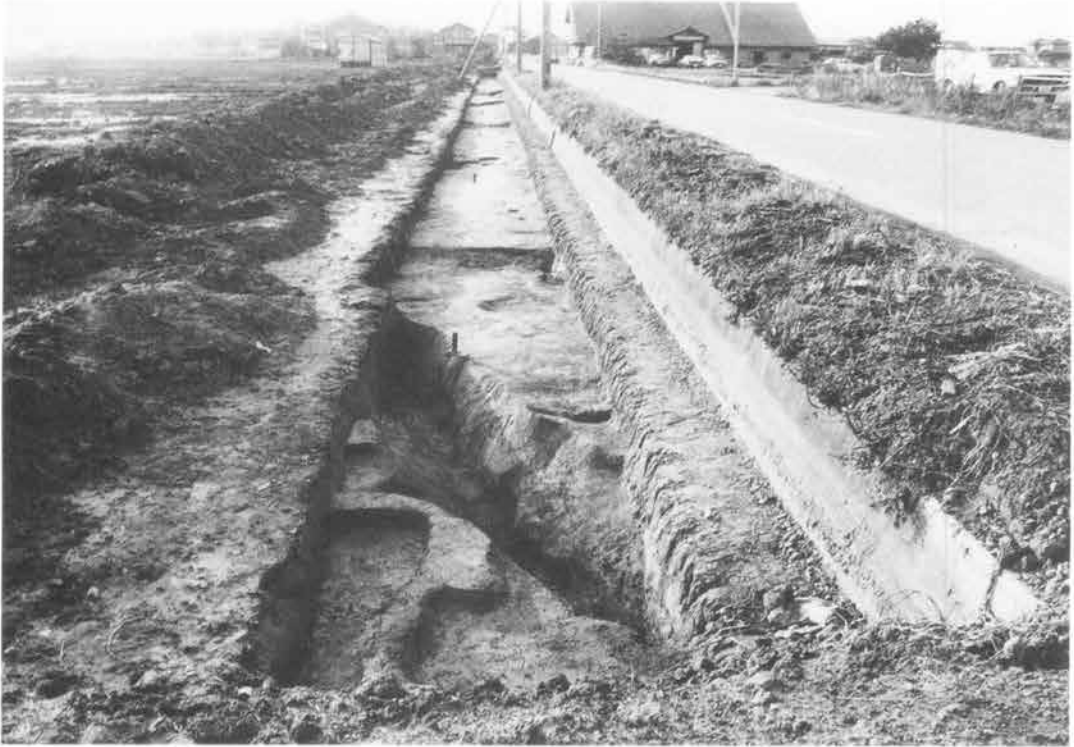
2 トレンチ完掘状況（東から。手前はSK 3、SD 9）
