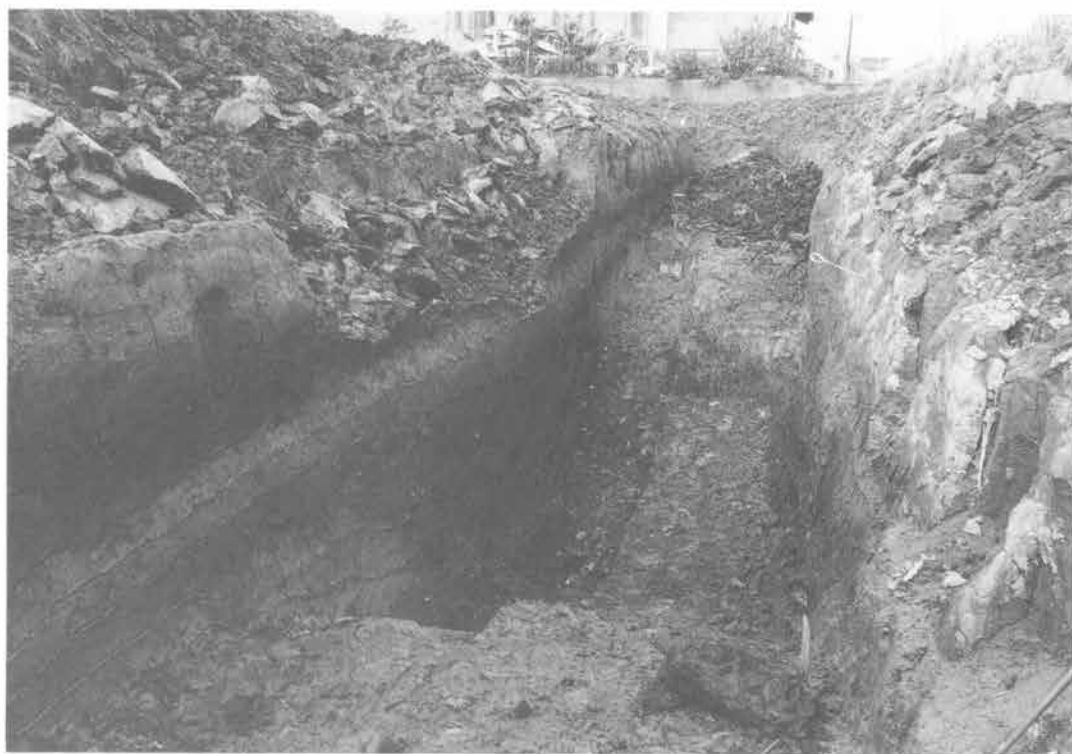
SD24完掘状況（北側は一部完掘していない。東北東から）
