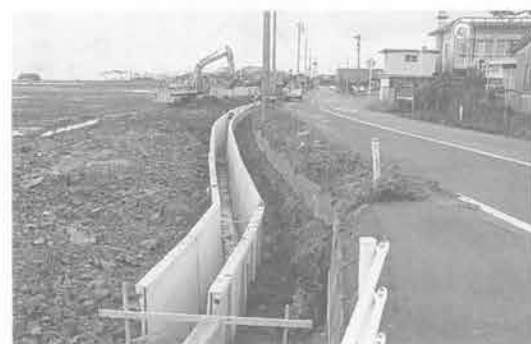
1トレンチ工事風景（東から）
