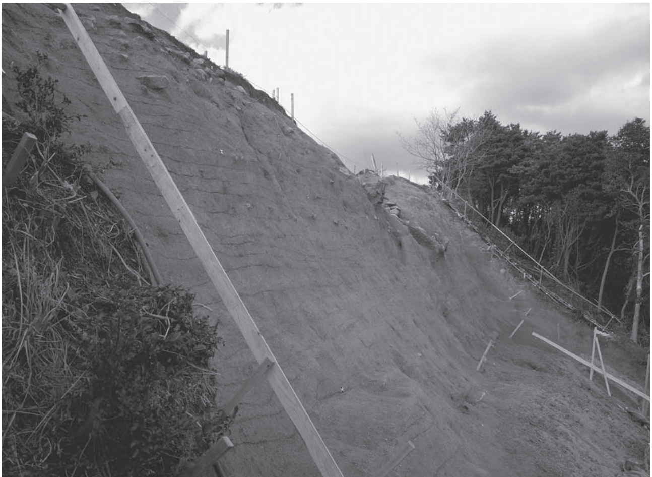
第 40 次調査 南地区 土壘版築状況（南から）
