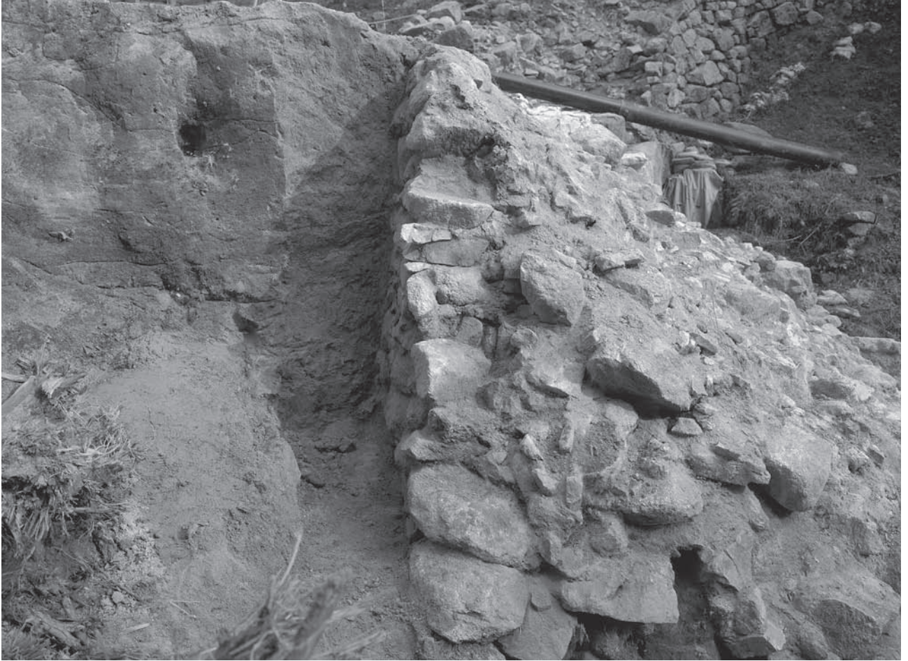
第 45-2 次調査 大石垣欠損部東側 断面石積み状況（西から）
