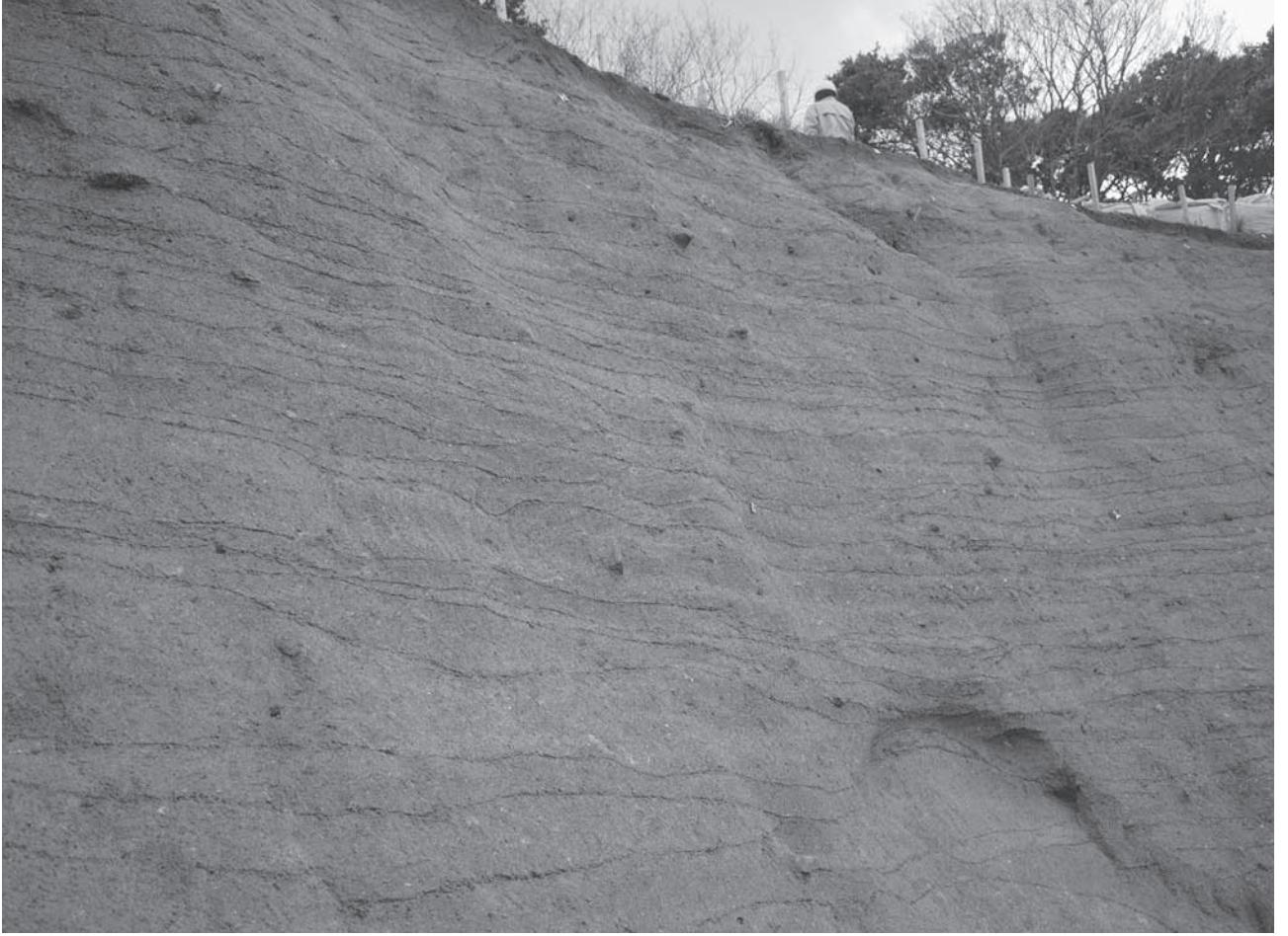
第 40 次調査 北地区 土塁版築近景（南東から）
