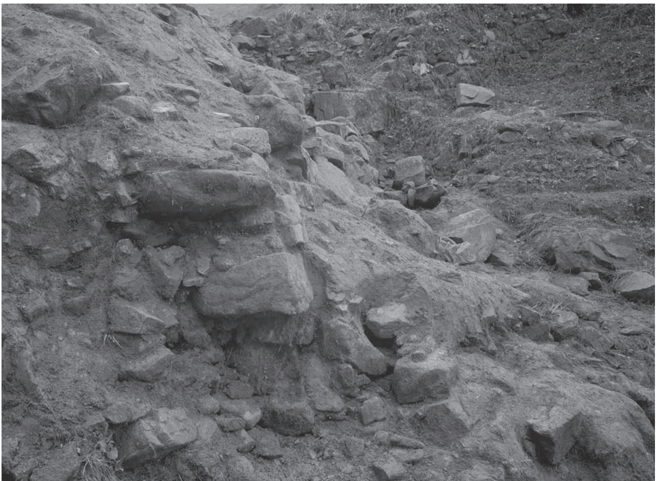
第 45 次調査 大石垣正面 積石崩落状況（西から）
