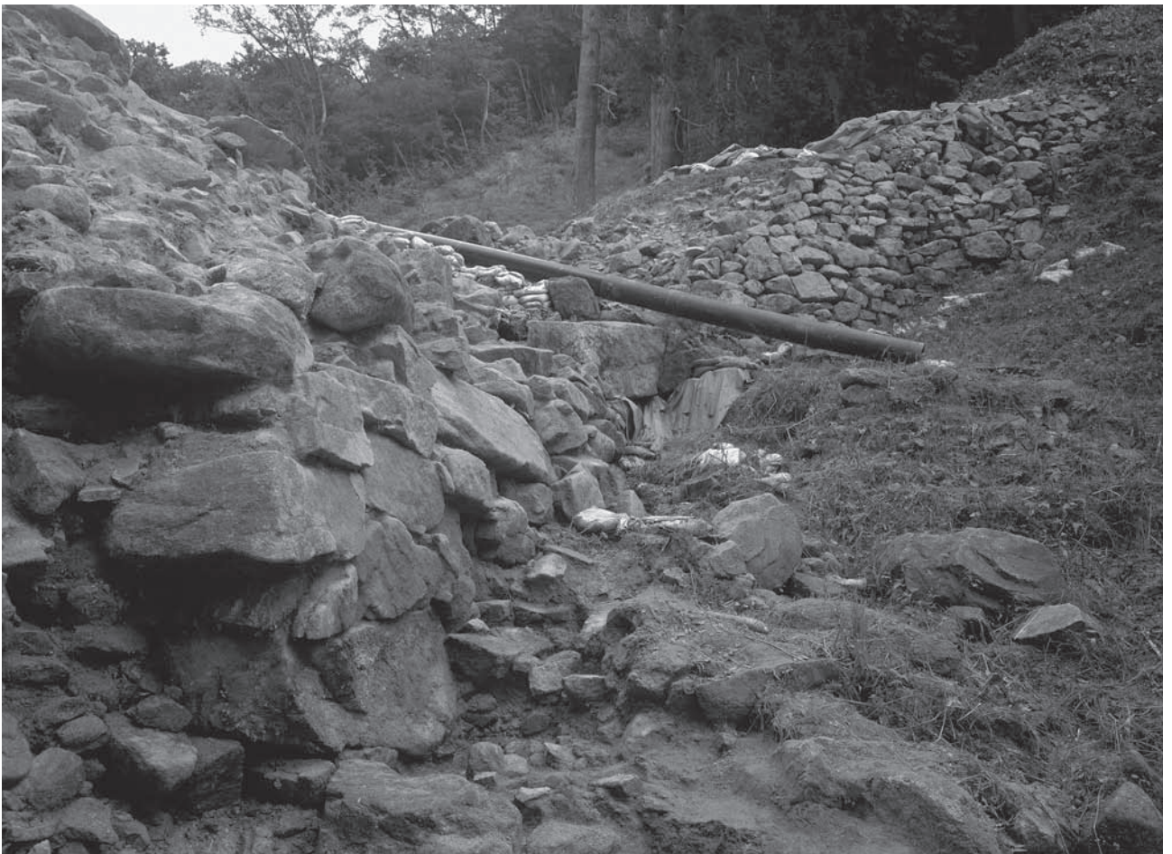
第45-2次調査 大石垣前面状況（南西から）
