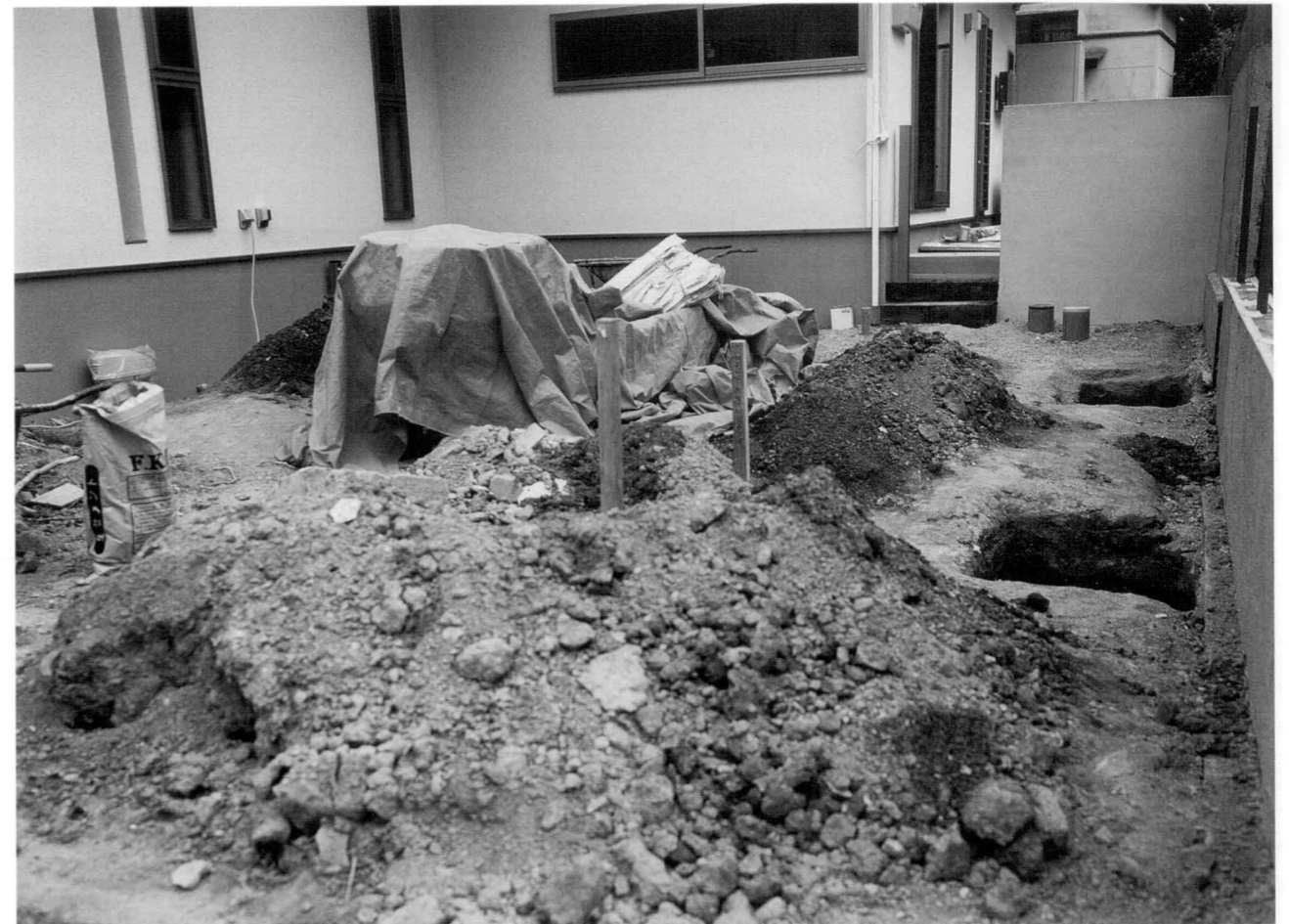
第 296 次調査地全景（東から）
