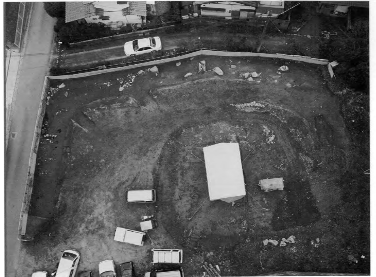
第19次調査2面目全景（上が東）
