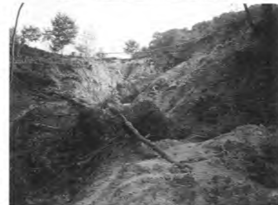
図6 平成15年座主跡石垣崩落の状況
