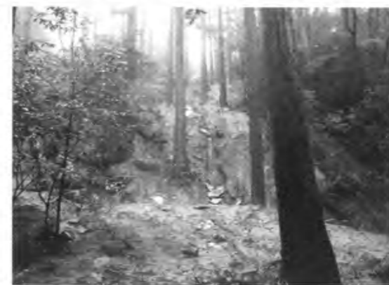
図7 平成24年座主坊崩落の状況
