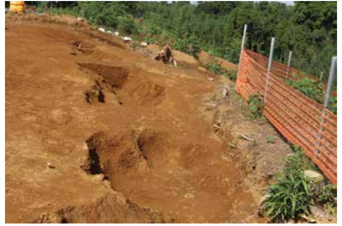
SD004 東側 南東から
