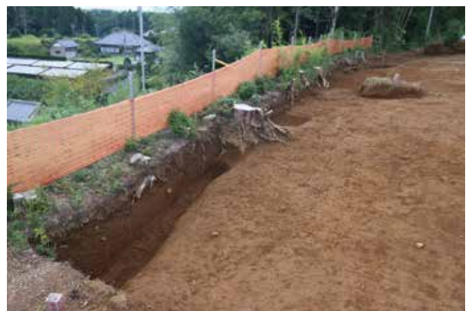
SD005 南西側 南東から
