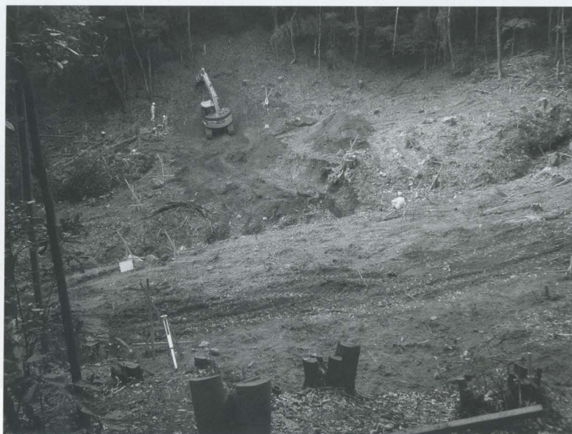
30. 本堤右岸 工事状況 （北から）
