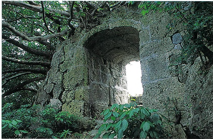
おものぐすく 御物城の石門 (北から)
