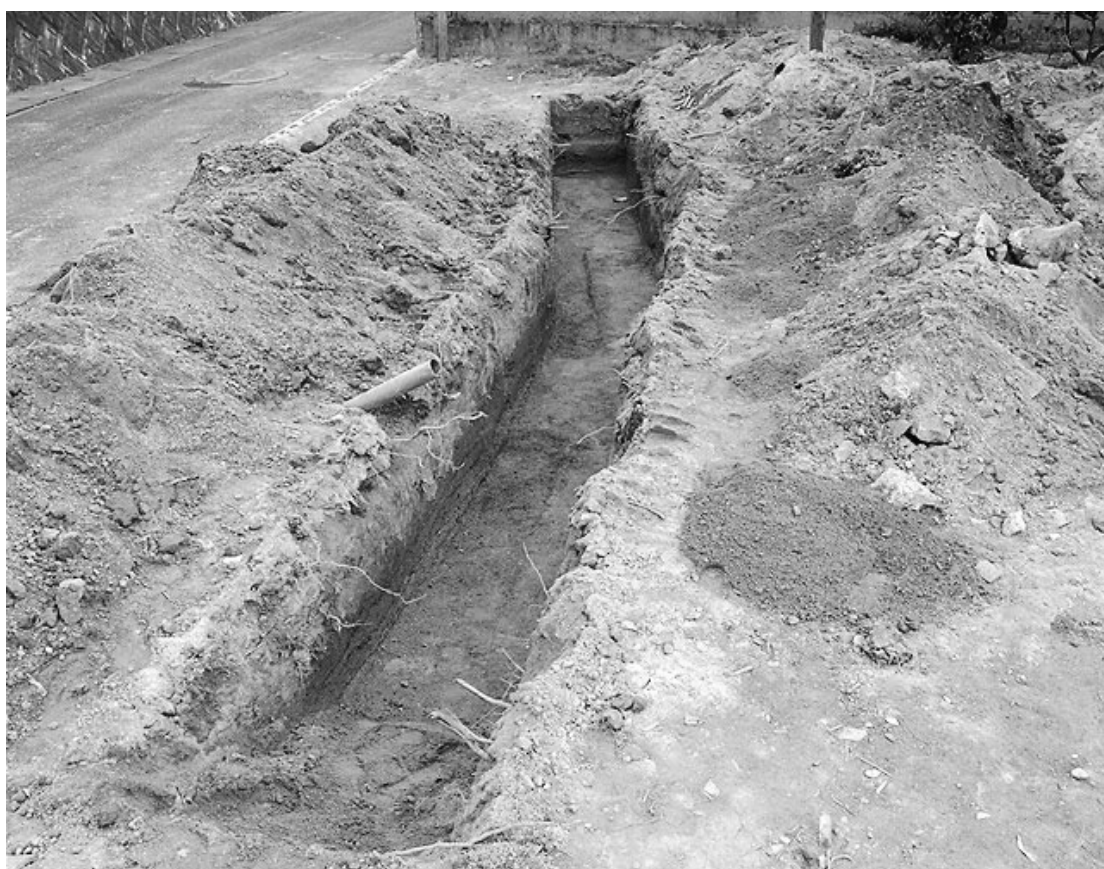
Pla13-2 尼18B トレンチ掘り下げ状況 (北から)
