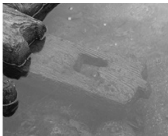
ホゾ穴状況 (SX003d) (西から)
