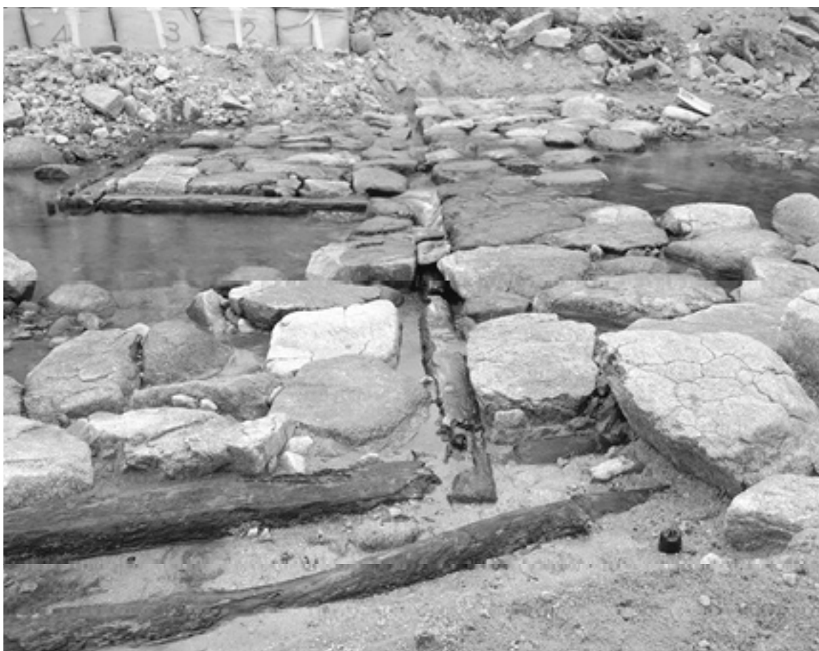
西側角材列 (SX002) (南から)
