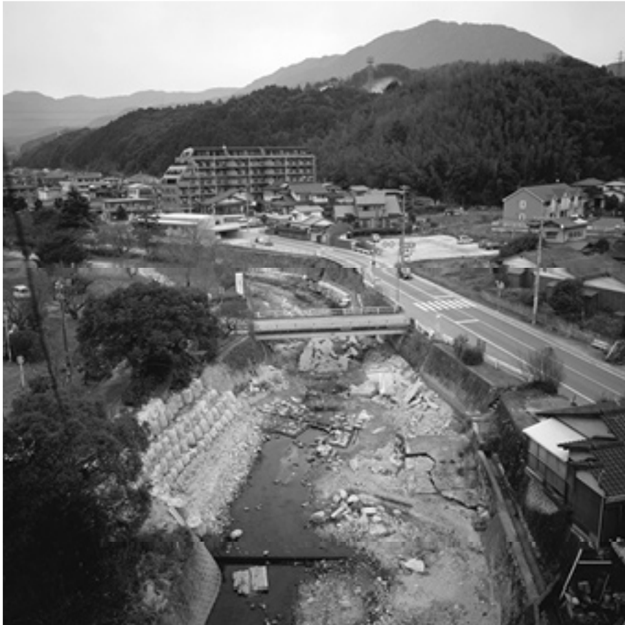
幸ノ元井堰第1次調査全景（西から）
