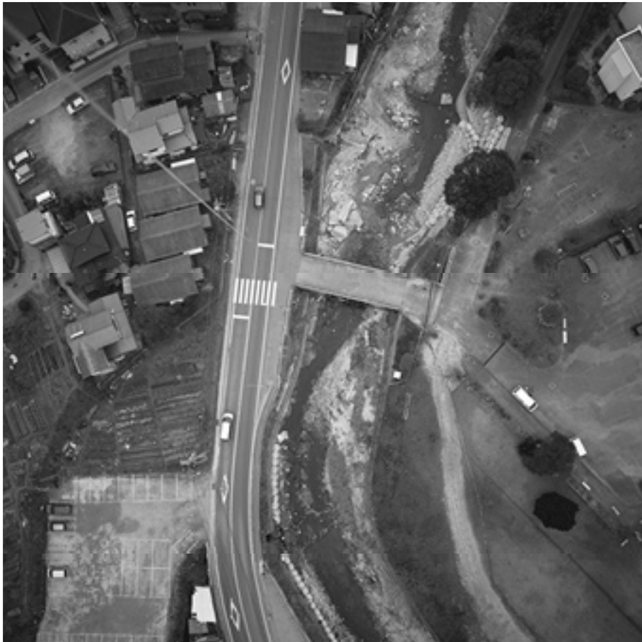
幸ノ元井堰第1次調査全景（右が北）
