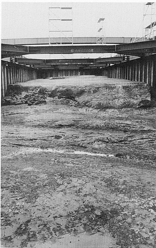
左-I トレンチNR4401左岸(南岸)
