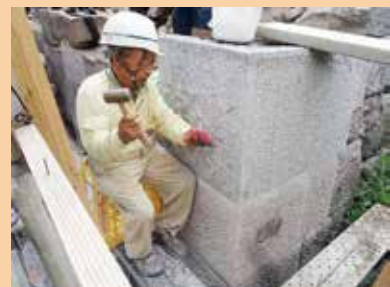
石材調整の状況を写真撮影
