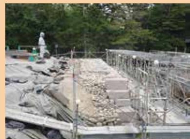
完成後に三次元レーザ計測を実施
