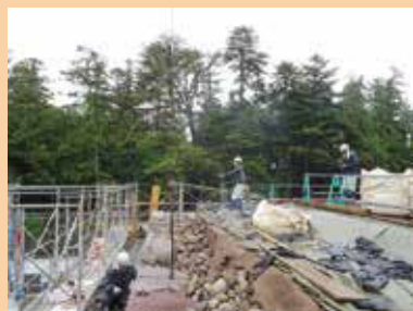
石垣の段ごとに写真測量を実施
