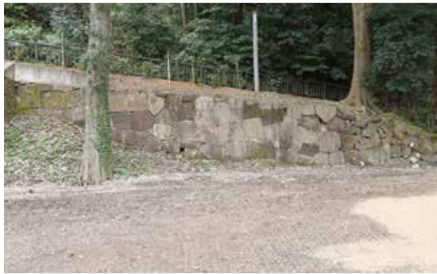
調査着手前状況 (西から)
