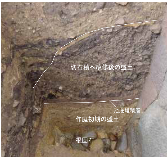
石垣前面の盛土と根固石
