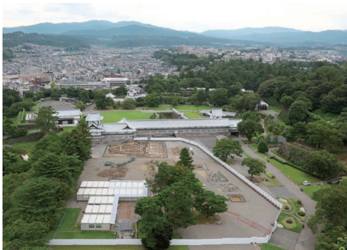
調査地点遠景（西から）
