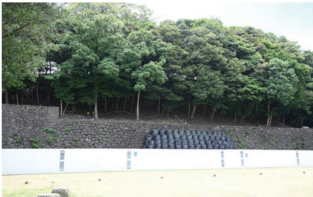
丸の内園地石垣の現況
