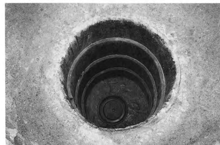
233SE050井戸枠詳細（西から）
