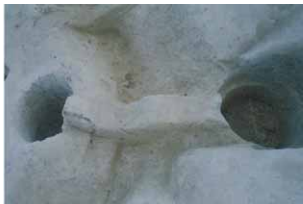
62. 7SX602・609完掘状況（北より）
