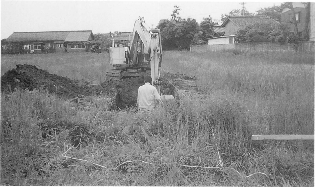
C区表土除去作業(北から)
