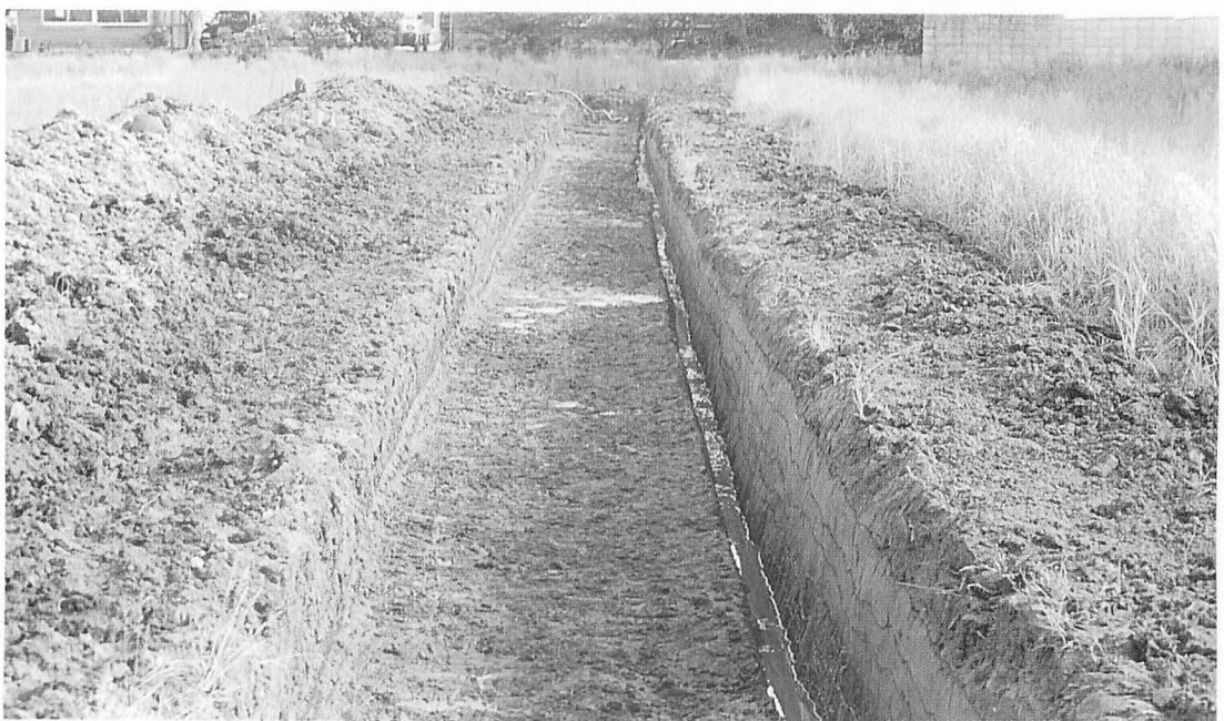
C区完掘状況(北から)
