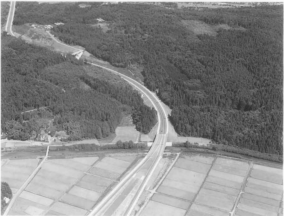
写真102 バイパス開通後の風景
