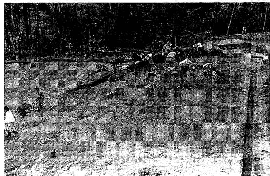
写真12 盛土除去作業
