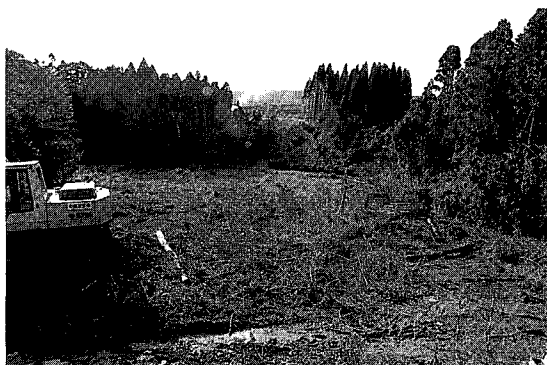
写真1 インナザカ地区からB22号墳を見る
