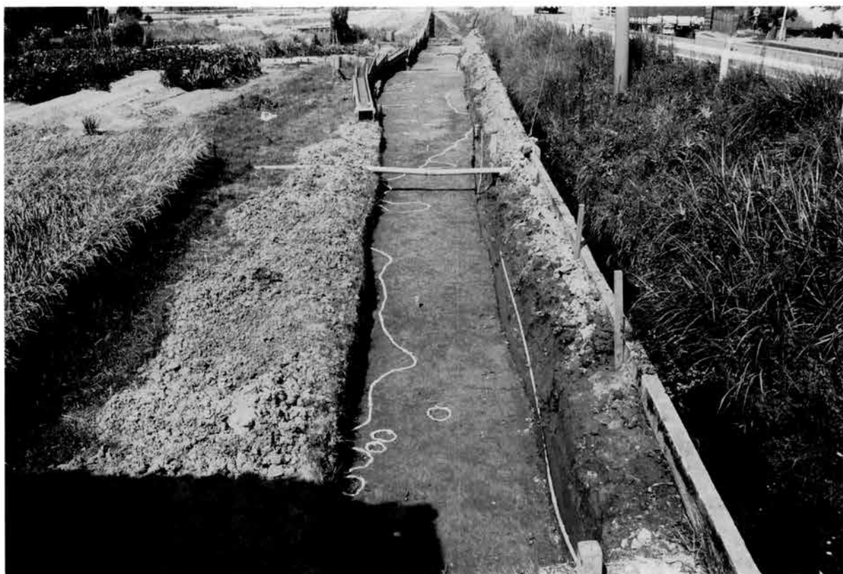
(1) 上層完掘状況（南西から）
