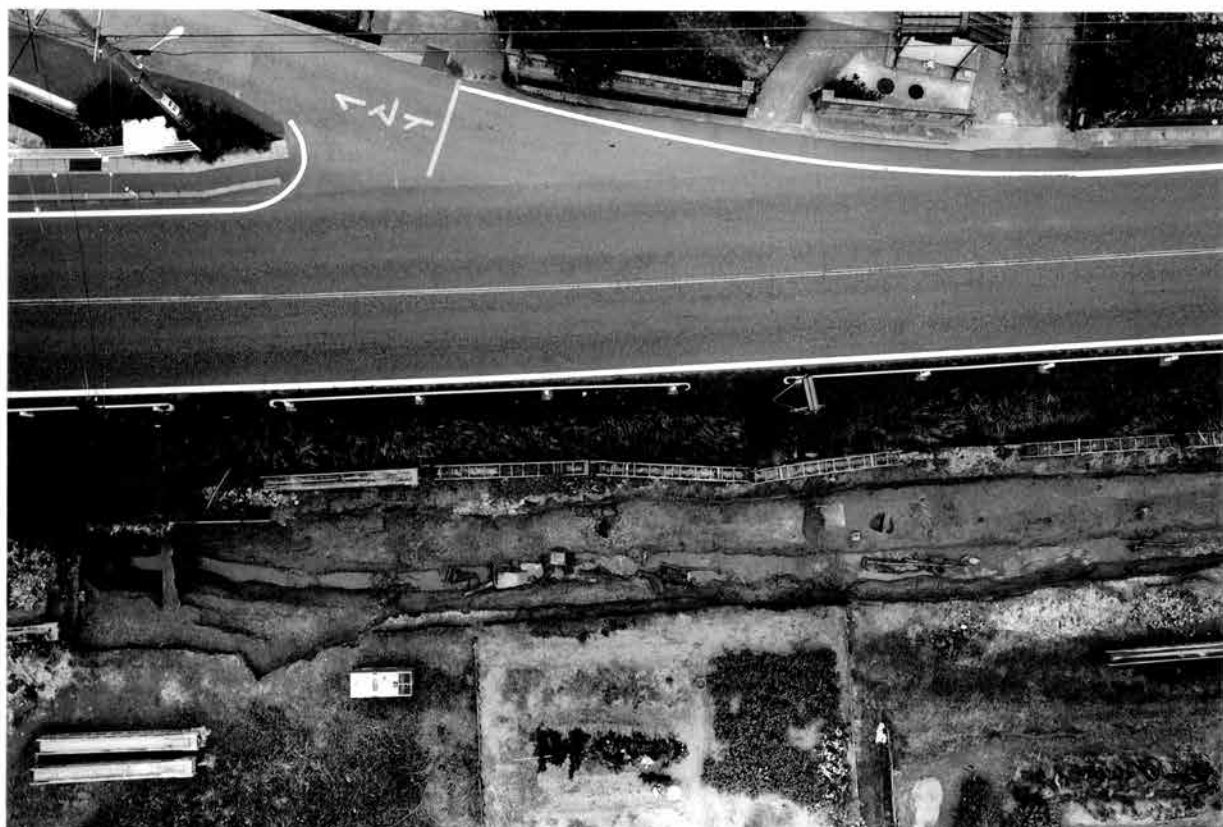
(1) 下層北半完掘状況
