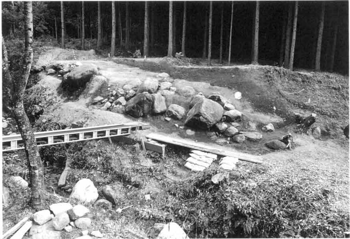
調査区全景 (北西より)
