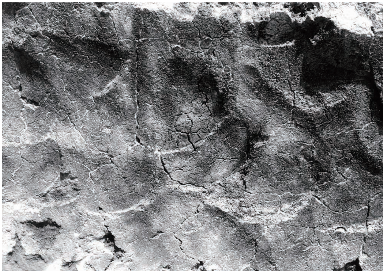
5号窯窯体北側壁工具痕
