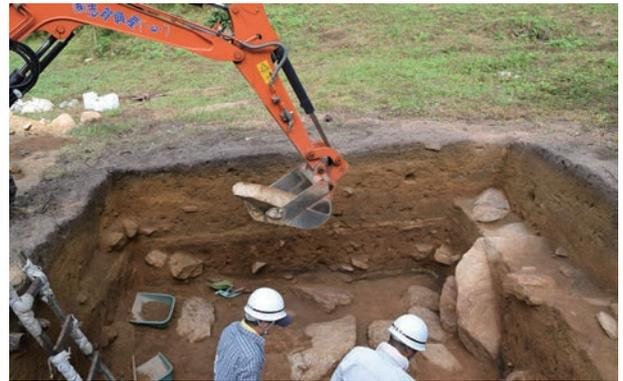
写真1-2 重機による崩落土除去 (R2-1tr)
