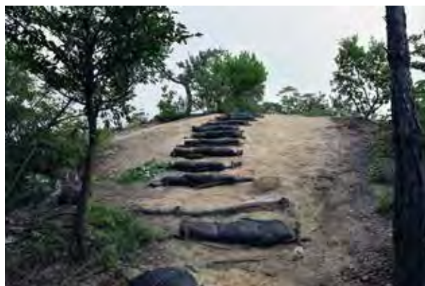
写真 4 - 34 山頂部への散策路1 整備後の状況 (平成 29 年 7 月 10 日撮影)
