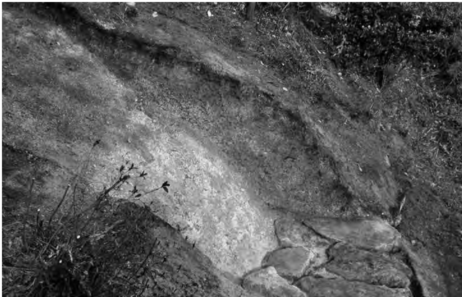
写真 22 H27 - 2トレンチ北壁断面
