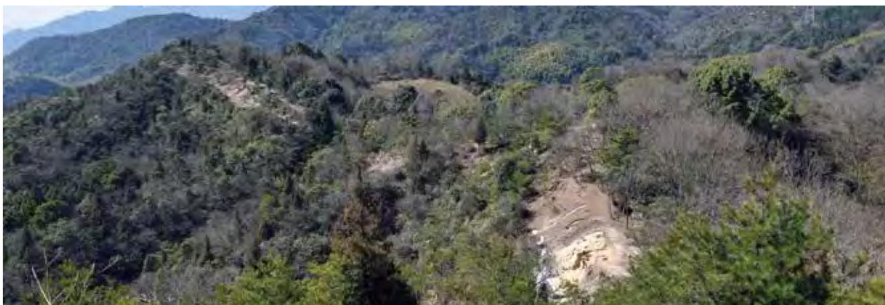
写真 4-29 東部頂上から見た南東部尾根 環境整備中 2(平成 29 年 3 月 30 日撮影)
