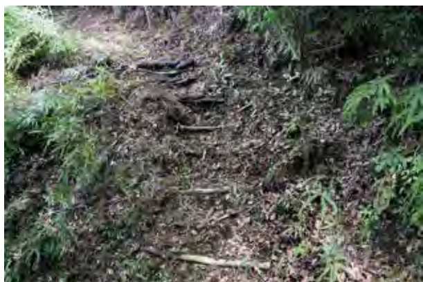
写真 4 - 17 南西部散策路 新ルート完成状況 (平成 28 年 6 月 27 日撮影)
