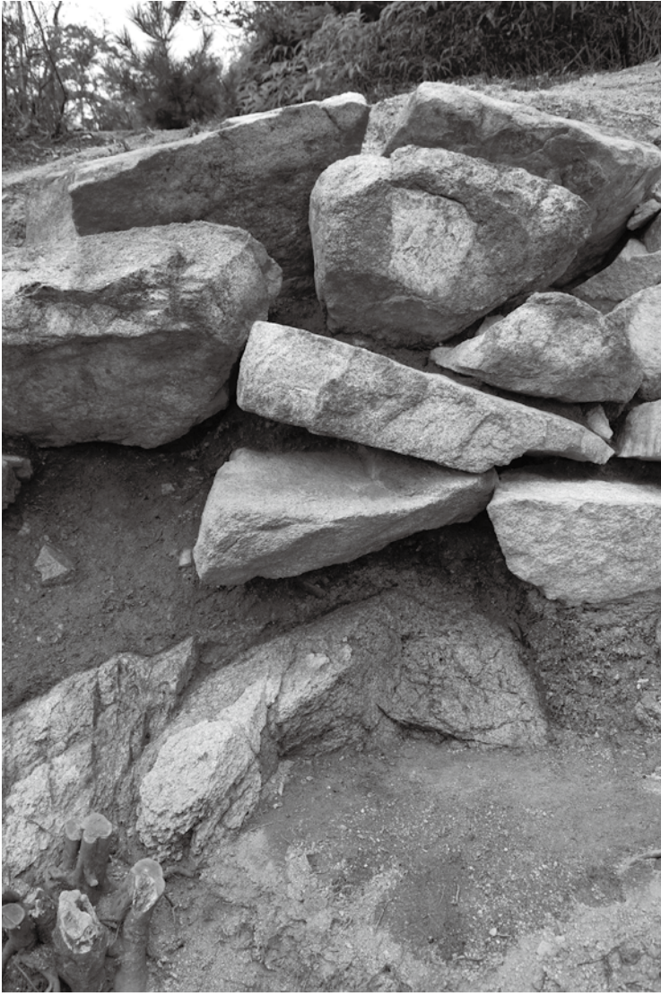
写真 44 南東部石積み（東から）
