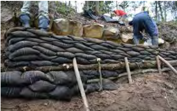
写真 4 - 21 南東部列石保護地点 1 段目整備作業状況 (平成 29 年 1 月 27 日撮影)
