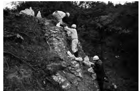
写真 1 - 3 H23 - 1 トレンチ 土のう除去作業風景
