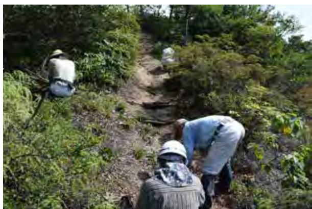
写真 4 - 37 山頂への散策路2 整備作業風景 (平成 29 年 7 月 3 日撮影)
