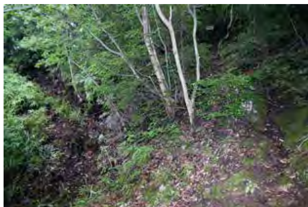
写真 4 - 16 南西部散策路 新ルート 施工中 (平成 28 年 6 月 24 日撮影)
