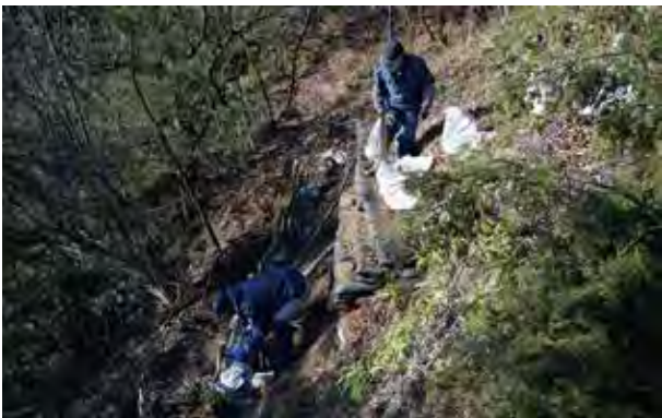
写真 4 - 23 南東部列石保護地点 2 段目整備作業状況 (平成 29 年 2 月 10 日撮影)
