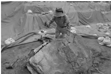
トレンチ内崩落石除去作業風景
