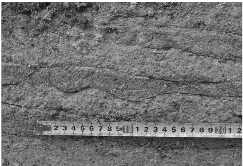
H23-1 トレンチ南区 土塁断割り西壁 版築の凹凸 (東から)
