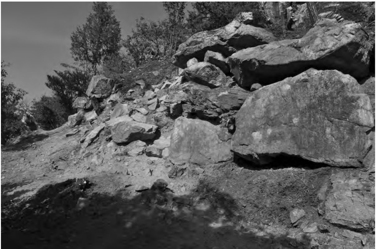
西部石積み 清掃後(2)(南西から)
