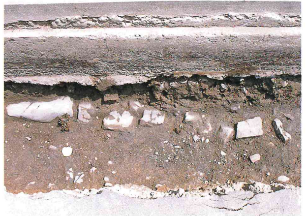
第22号石列検出状況 南から
