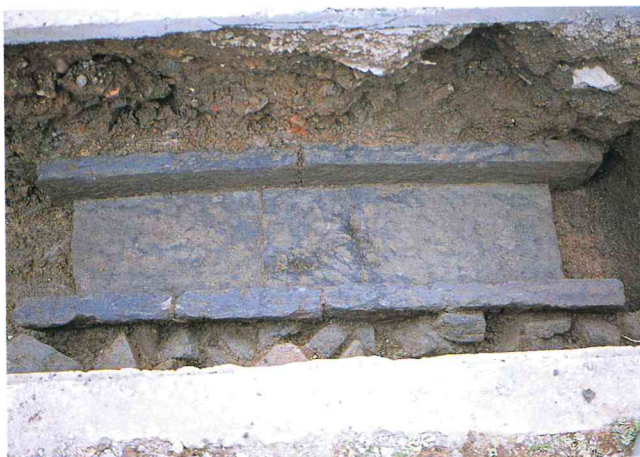
2号側溝検出状況 南から
