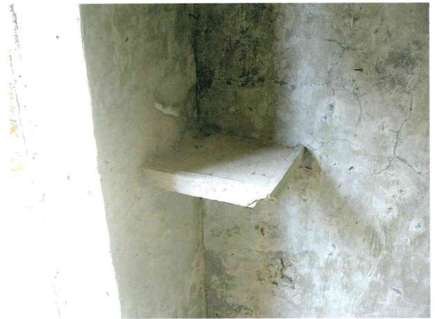
コンクリート造建物跡 内部東壁面 西より
