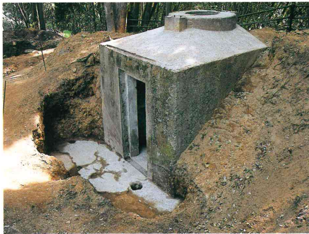
コンクリート造建物跡 入口 西より
