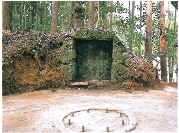
1号砲台跡 弾薬庫 東から
